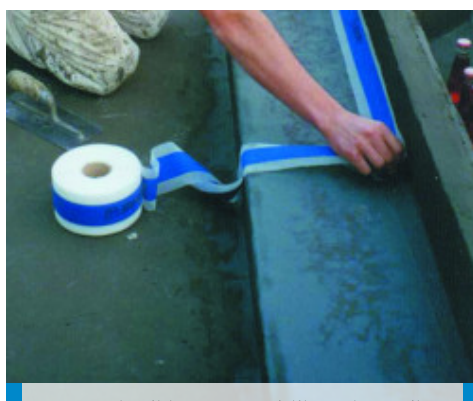
Esempio di impermeabilizzazione di Mapeband dell'angolo tra fondo e parte di una vasca
