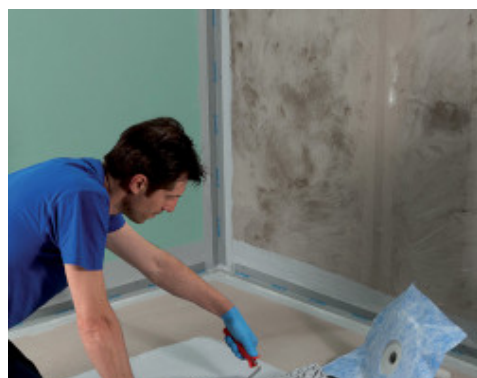
Applicazione di Drain Vertical mediante Mapegum WPS
