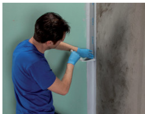
Applicazione di Mapeband PE 120 mediante Mapegum WPS
