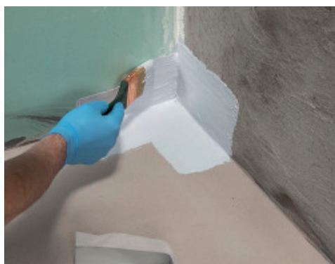
Applicazione angolo 90° di Mapeband PE 120 mediante Mapegum WPS
