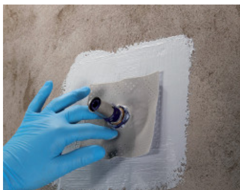
Applicazione di guarnizione per fori passanti di Mapeband PE 120 mediante Mapegum WPS
