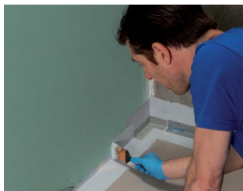
Applicazione di Mapeband PE 120 mediante Mapegum WPS
