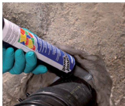
Applicazione di Mapeproof Swell intorno al tubo
