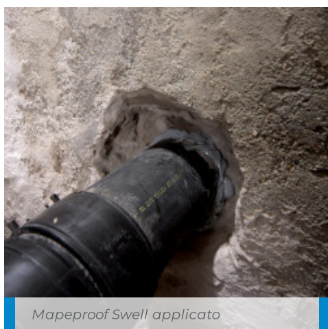
Demolizione della struttura intorno al tubo
