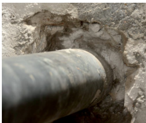
Demolizione della struttura intorno al tubo
