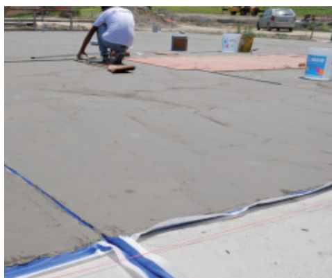
Impermeabilizzazione dei massetti con Mapelastic Zero e Mapeband
