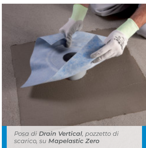
Impermeabilizzazione dei massetti con Mapelastic Zero e Mapeband
