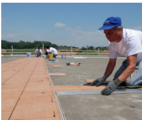
Posa di ceramica con Kerabond + Isolastic
